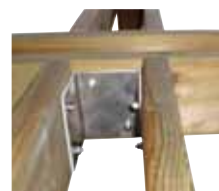
Sammansvetsat U-järn för stark konstruktion i bärlinor.
