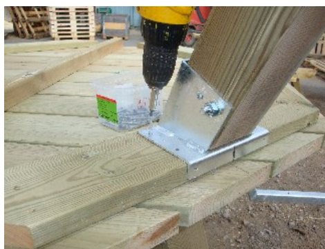
Montera därefter hylsan med 7 st. ankarskruvar.
