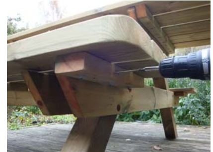
Fäst varje sits med 3 st. trallskruv vardera sida.
