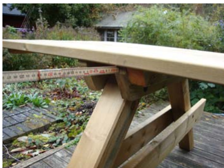
Centreringar. 14-16 mm på vardera sida av bordet.
