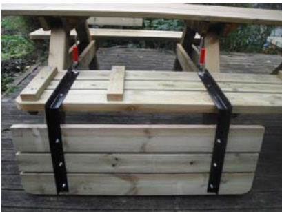
Vänd sittbrädan upp och ner vid montering av ryggstöden.
