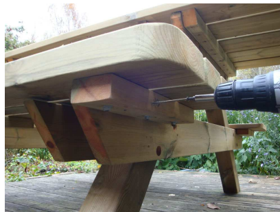
Fäst varje sits med 3 st. trallskruv vardera sida.
