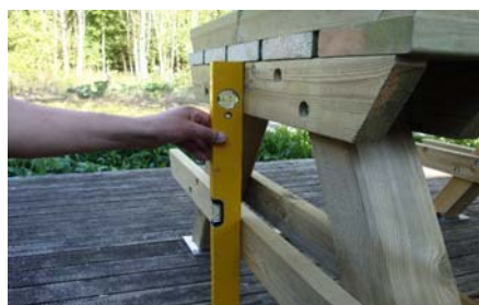
Kontroller i lod
