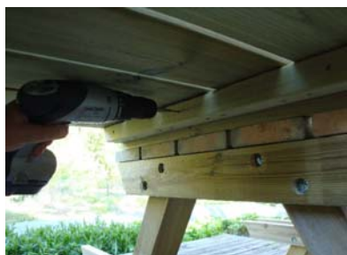
Fastmontering av det höga bordet mot det låga
