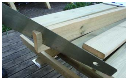
Såga ut rätt längd av snedsträvan
