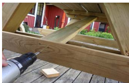
Skruva fast i benpar
